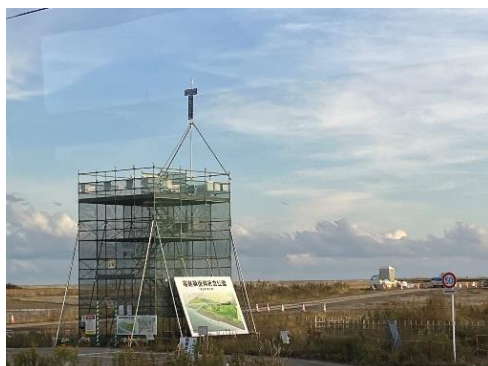
←左は建設中の「福島県復興祈念公園」。2025 年完成予定。T 字が津波の高さ 16.5m。
